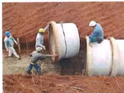
Foto 5 - Assentamento dos tubos de concreto
