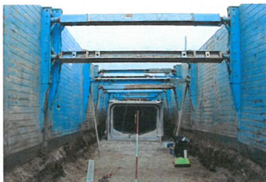
Figura 1 - Escoramento Blindado em galeria de seção retangular Figura 2 - Escoramento Blindado em galeria de seção circular
